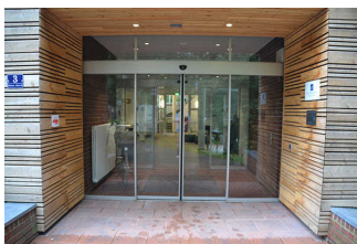
Türen außen (vor Windfang)
